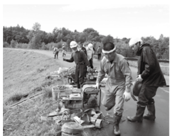
施設の冠水と排水作業
