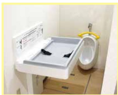
1階女子トイレに新設された小児用トイレ/おむつ替え台
