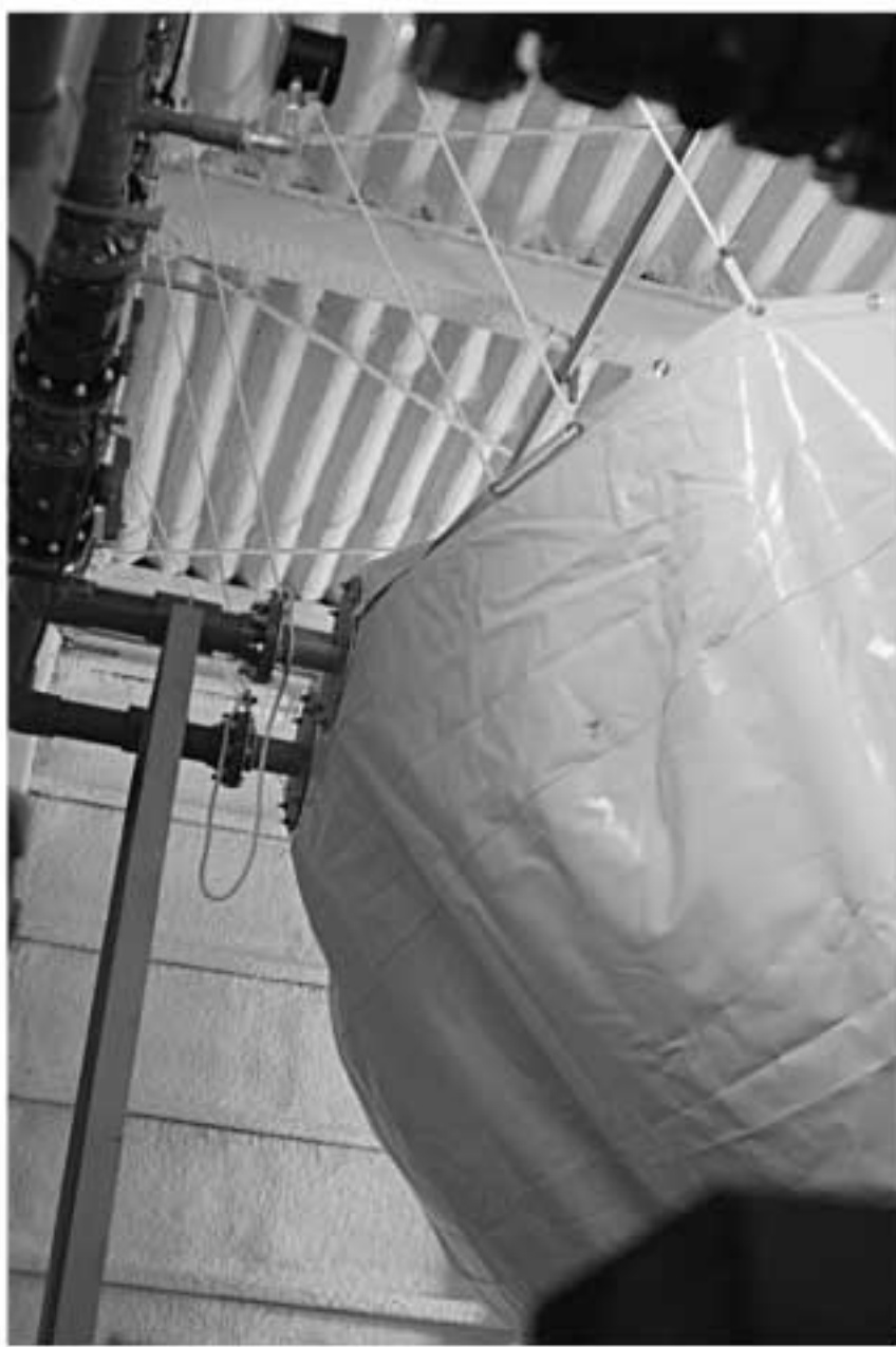
(上)家畜の尿と糞を区別する固液分離機 (左)メタンガスを一次的にバックに貯留 (左下)ガス発生を促進する大型ボイラー (下)発電のかなめ、駆動エンジン (最下)スラリーストアー
