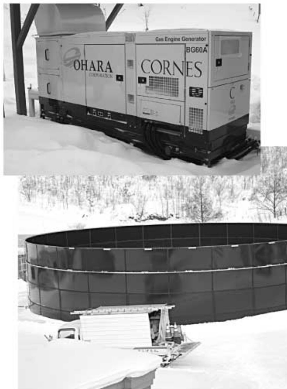
(上)家畜の尿と糞を区別する固液分離機 (左)メタンガスを一次的にバックに貯留 (左下)ガス発生を促進する大型ボイラー (下)発電のかなめ、駆動エンジン (最下)スラリーストアー
