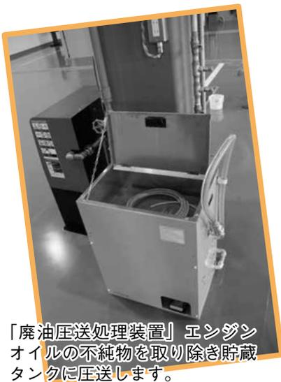
「廃油圧送処理装置」エンジンオイルの不純物を取り除き貯蔵タンクに圧送します。
